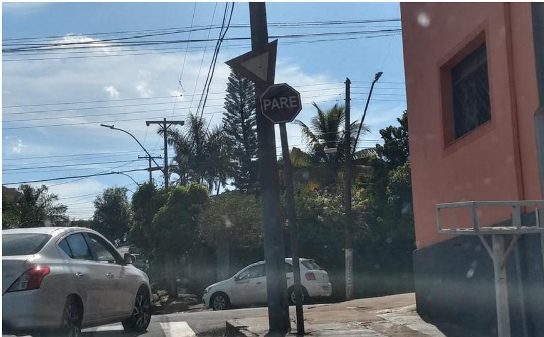
**Figura 14 – Placa de regulamentação e sinalização horizontal fora de padrão - Rua Ciro Bergamaschi**
