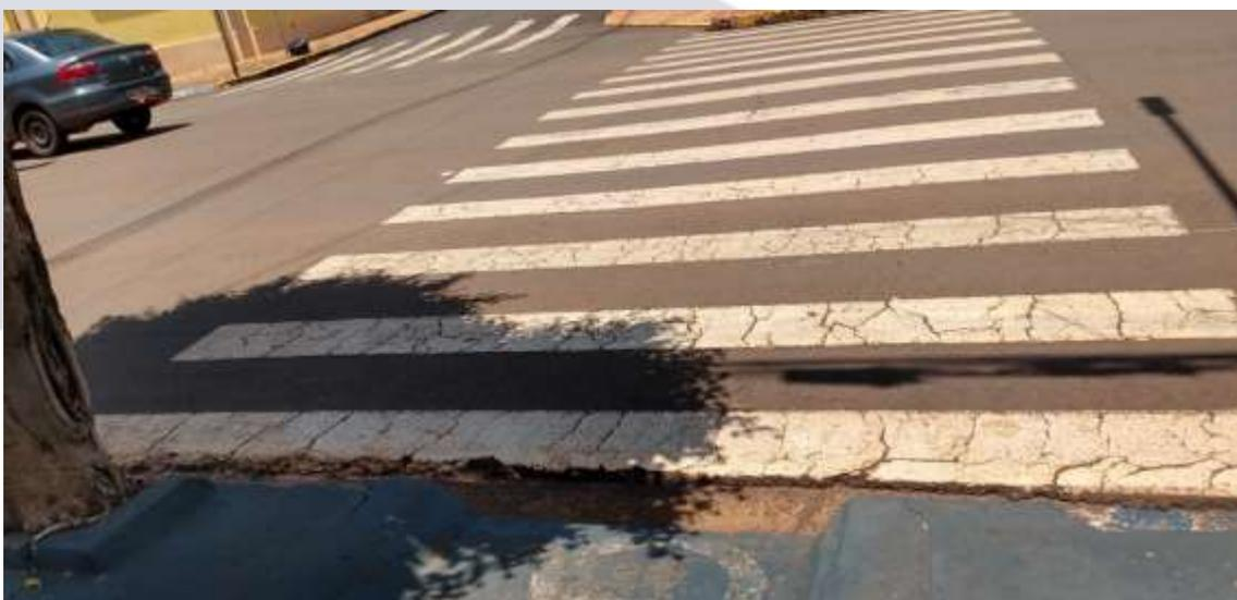
Figura 68 – Travessia de pedestres com apenas um lado contendo rampa acessível.
