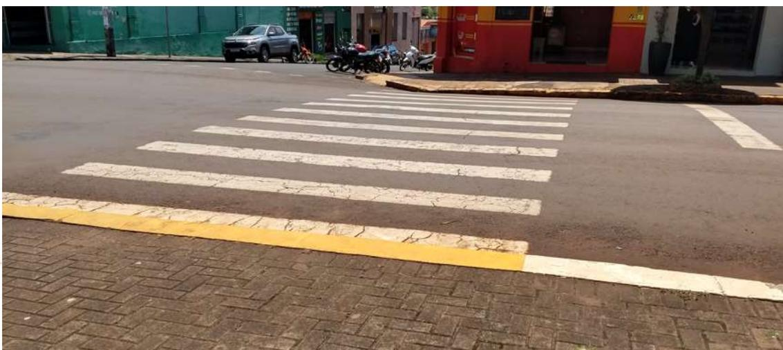
**Figura 23 – Falta de Sinalização horizontal rampas em desconformidade – R. Maj. Barbosa**
