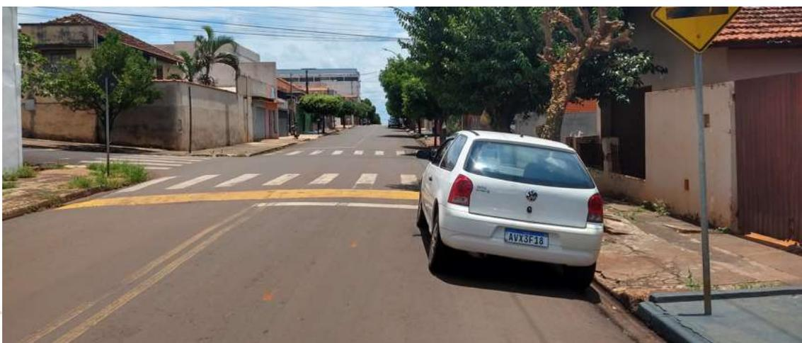
**Figura 72 – Travessia de pedestres com apenas um lado com acessibilidade**
