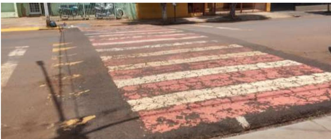
Figura 78 – Travessia de pedestres com rampa em péssimo estado
