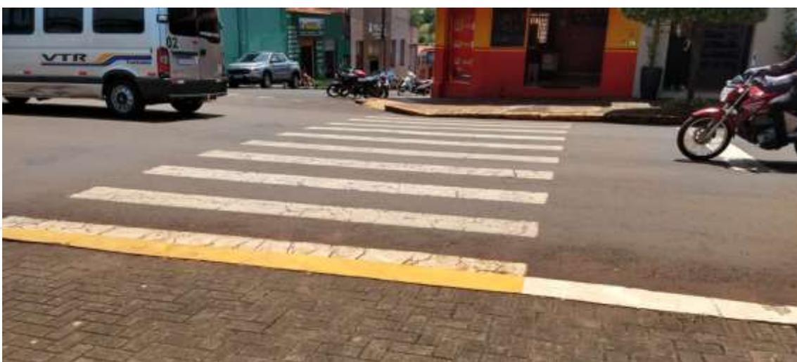
Figura 70 – Travessia de pedestres com rampas desalocadas e faixa em péssimo estado
