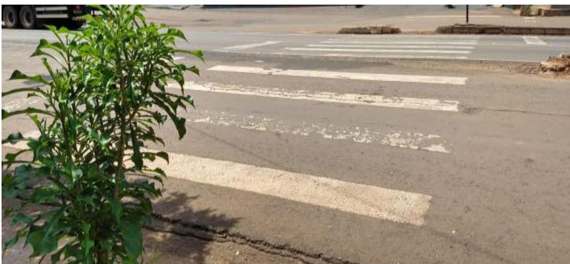
**Figura 61 – Travessia de pedestres sem acessibilidade e faixa em péssimo estado de conservação – ROD. 367**
