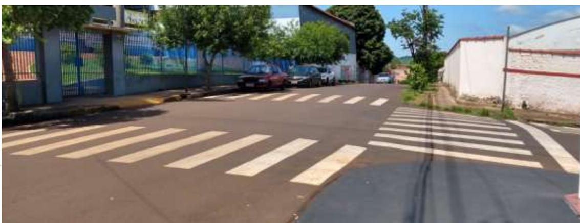
**Figura 56 – Travessia de pedestres com acessibilidade apenas no canteiro**
