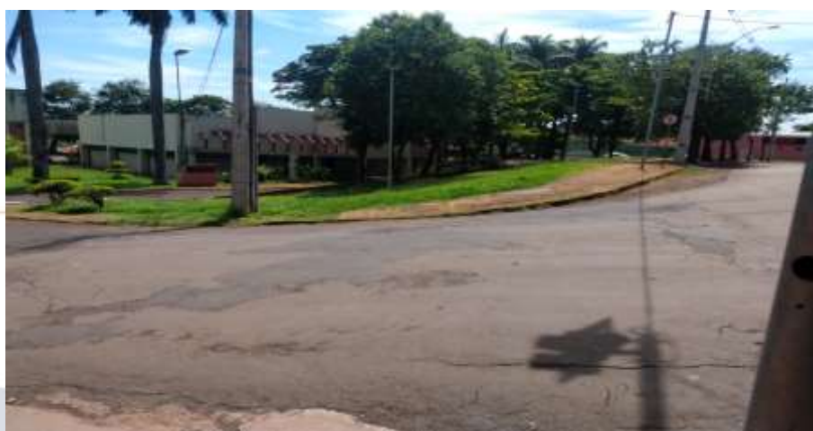
Figura 10 – Falta de rampa de acessibilidade a calçada em frente a rodoviária
