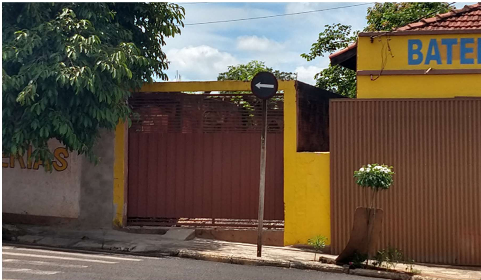
Placa em desacordo com a legislação - Rua Nossa Senhora do Roccio
